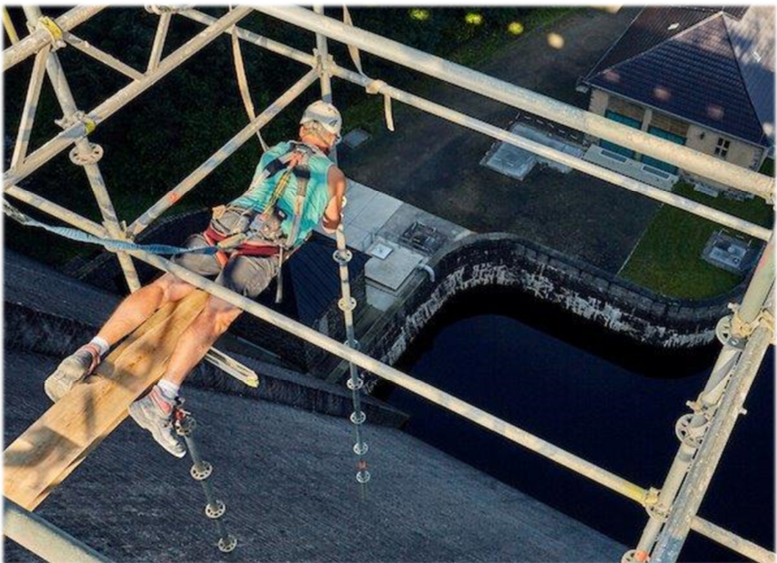
Gemeinhardt Gerüstbau Service GmbH: Talsperre Lehmühle, Sachsen
