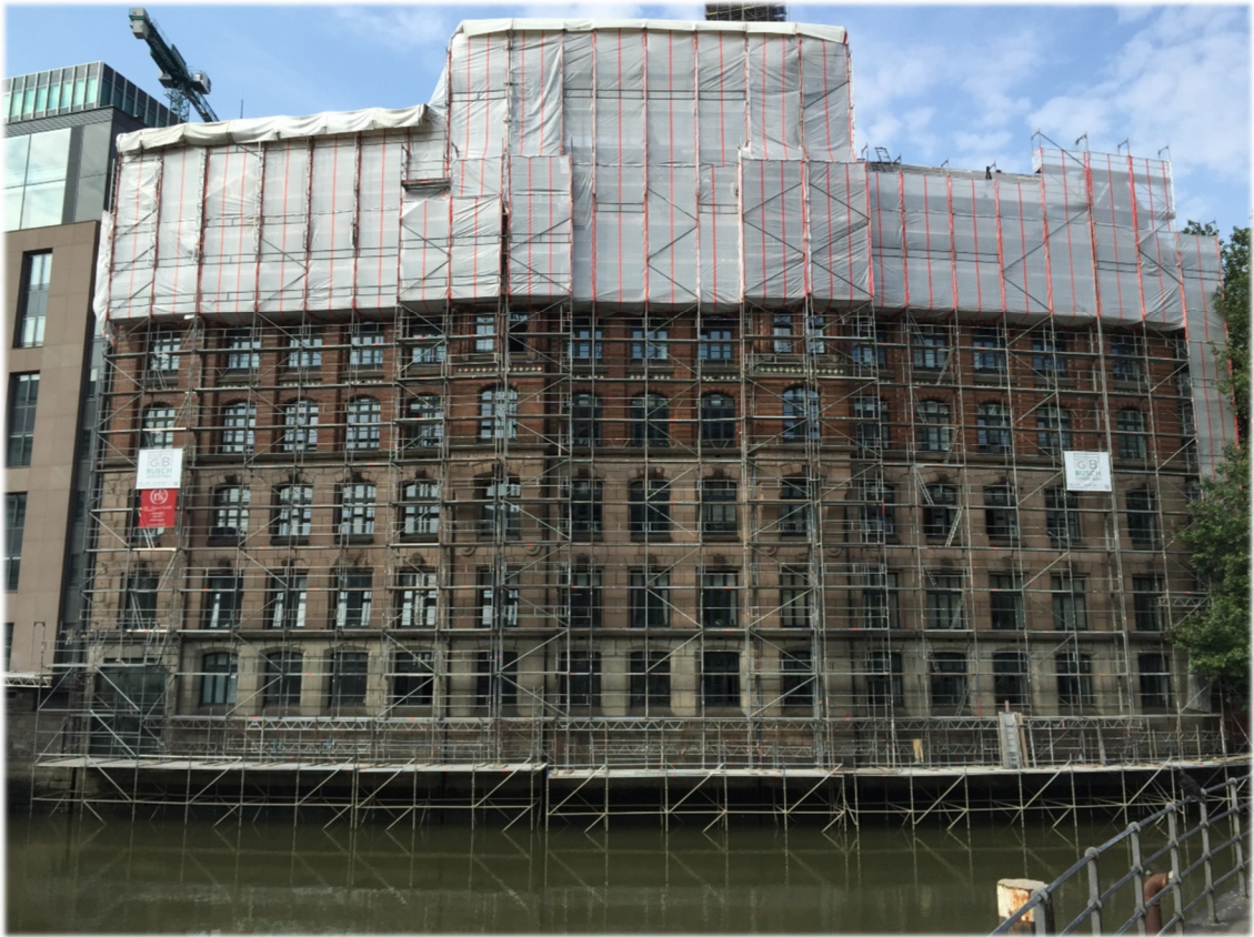
Gerhard Busch Gerüstbau GmbH: Arbeits- und Schutzgerüst mit Gründung in ein bis vier Meter Wassertiefe, Trostbrücke, Hamburg
