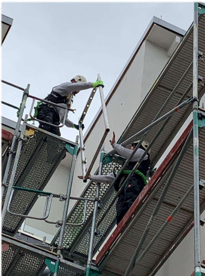
Gerüstbau Meisterbetrieb Kolb GmbH: Neubaugebiet Griesheim, Hessen
