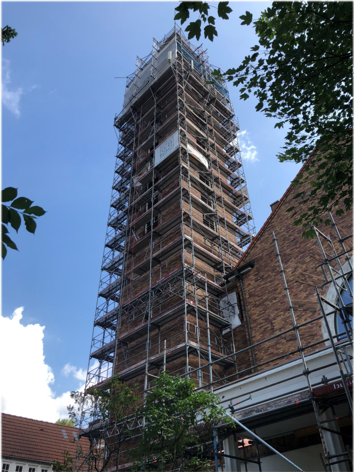
Gerhard Busch Gerüstbau GmbH: Arbeitsgerüst Frohbotschaftskirche, Hamburg
