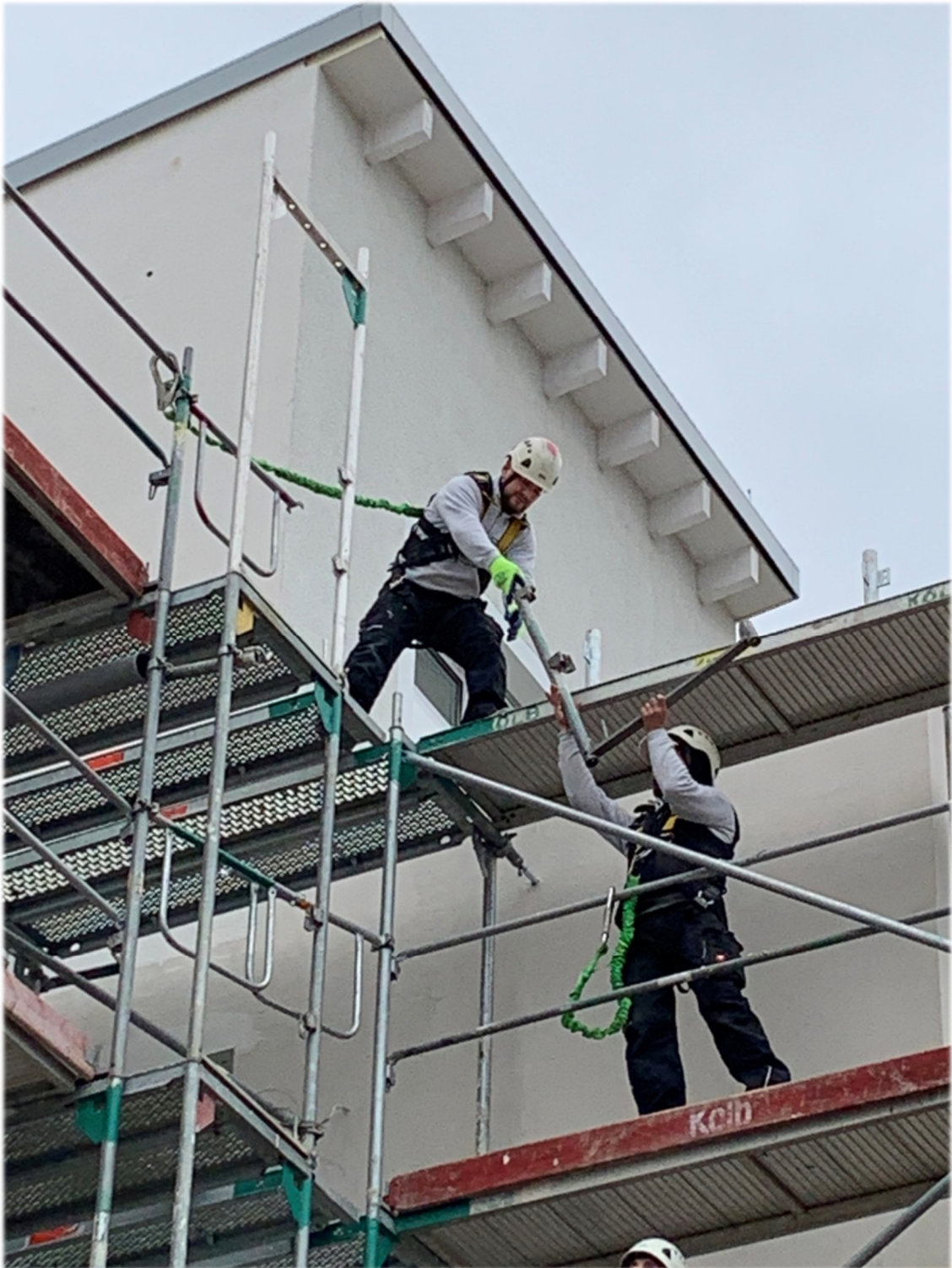
Gerüstbau Meisterbetrieb Kolb GmbH: Neubaugebiet Griesheim, Hessen
