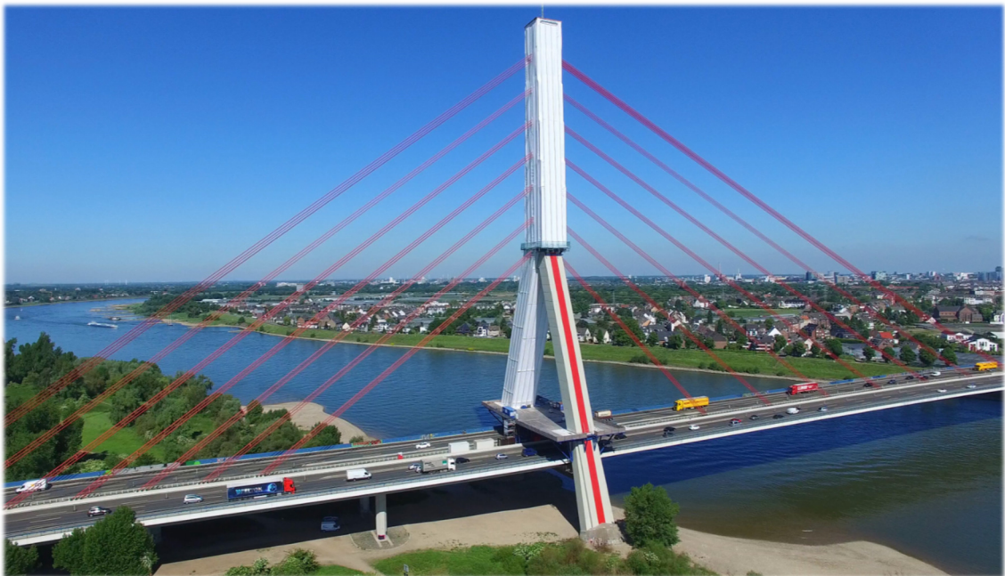
Teupe & Söhne Gerüstbau GmbH: Fleher Brücke, Düsseldorf/Neuss
