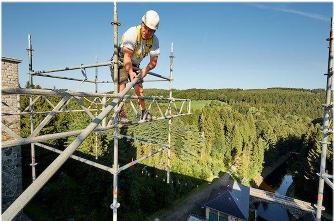
Gemeinhardt Gerüstbau Service GmbH: Talsperre Lehmühle, Sachsen
