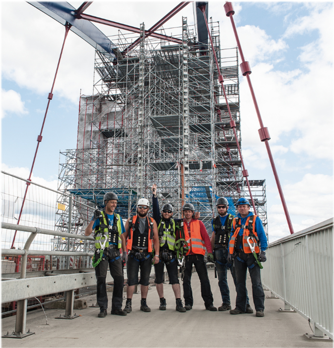
ALTRAD plettac assco GmbH: Elbbrücke bei Dömnitz, Brandenburg
